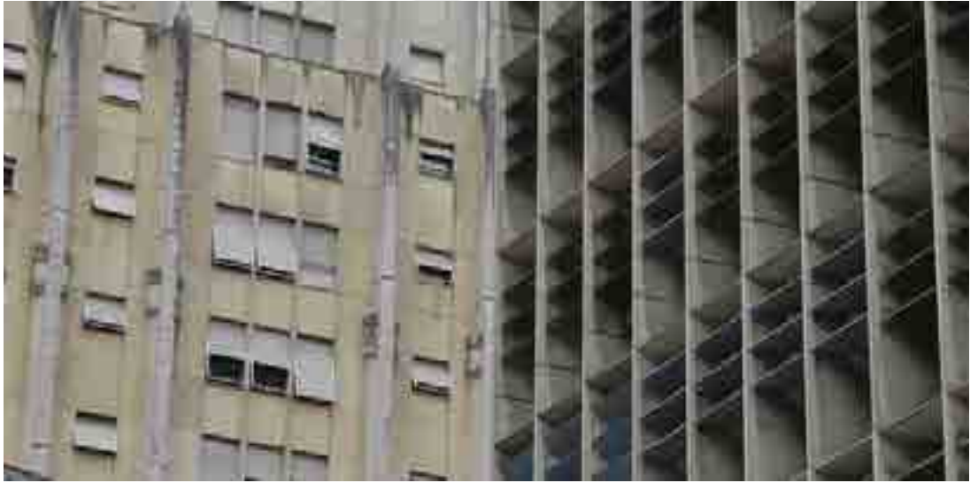
Resim3.15.MES Binası (1936-1943, Rio de Janeiro, Brezilya) (modern-brezil-architecture.blogspot.com.tr; www.architravel.com)
